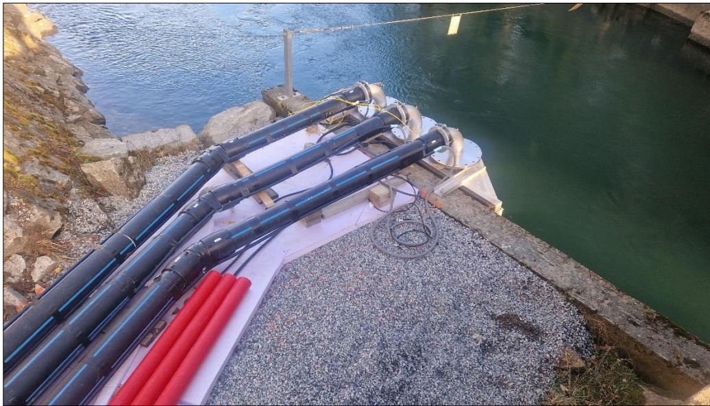
Figur 10. Installasjon av pumper for uttak av vann fra kanal.
