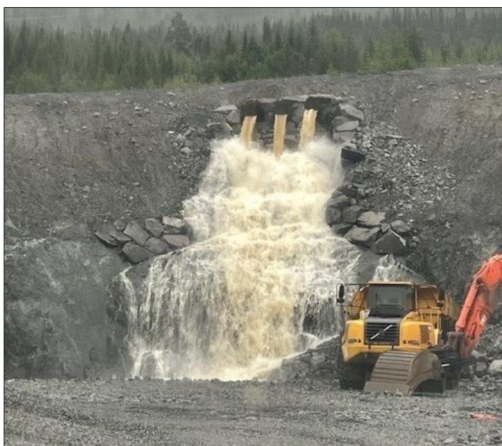
Figur 13. Bilde av stikkrenner under adkomstveg til høydebasseng, kl 8.00 ved flommen Hans i 2023
