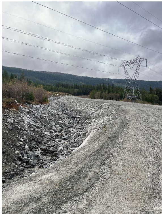
Bilde 11: Grøfta langs veien til høydebasseng.
