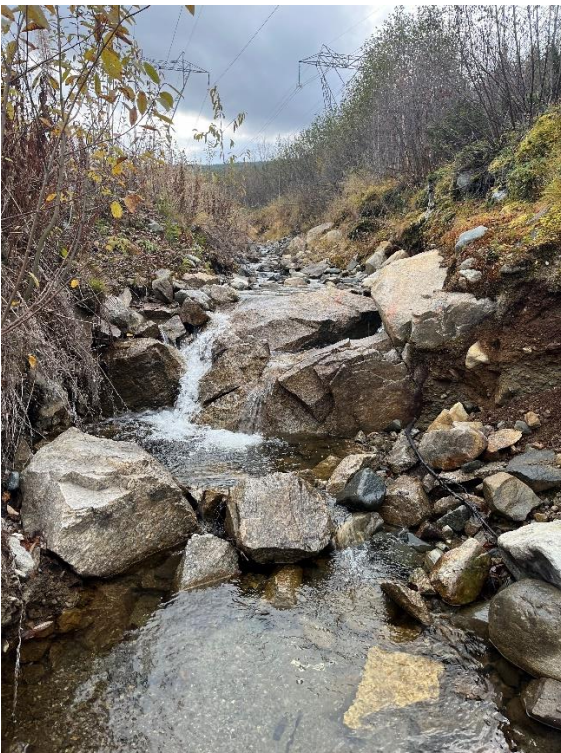
Bilde 10: Grøfta langs veien til høydebasseng.
