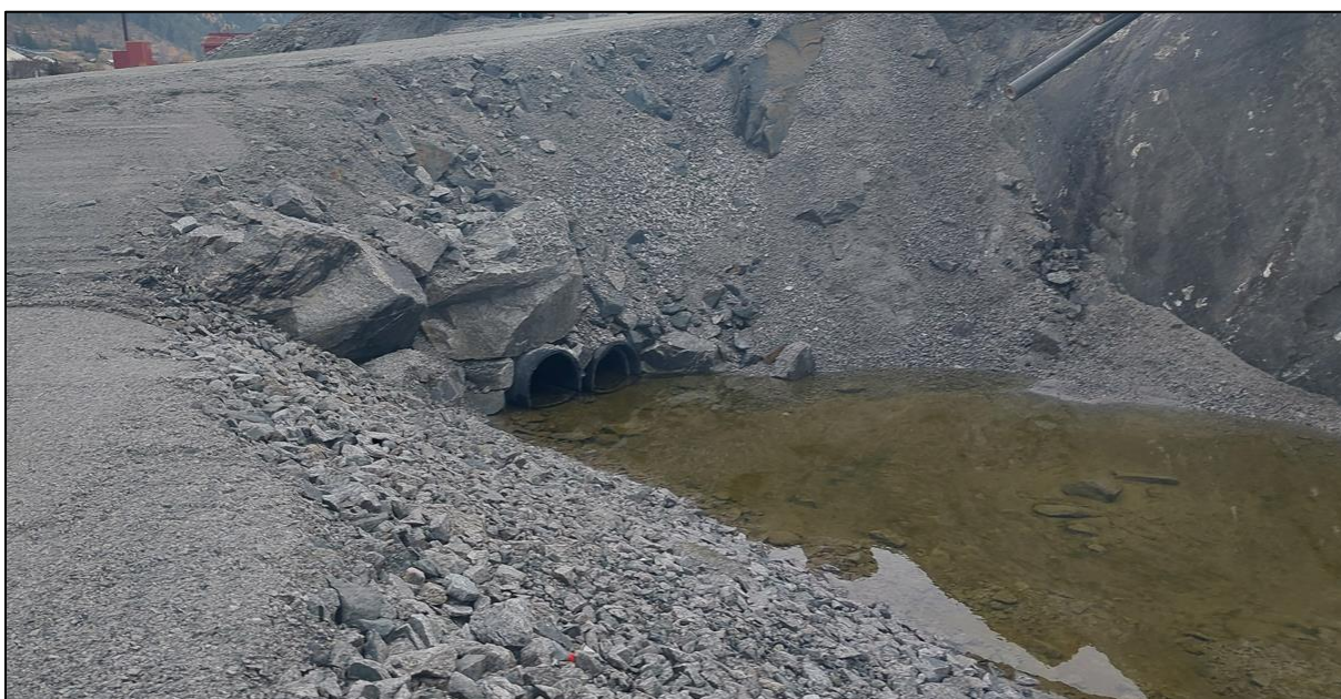
Figur 9: Delstrekning 4: 2x800 mm rør
