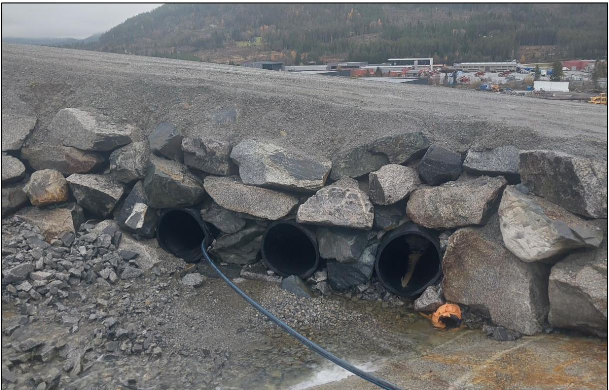
Figur 7: Delstrekning 2: 3x1000 mm rør
