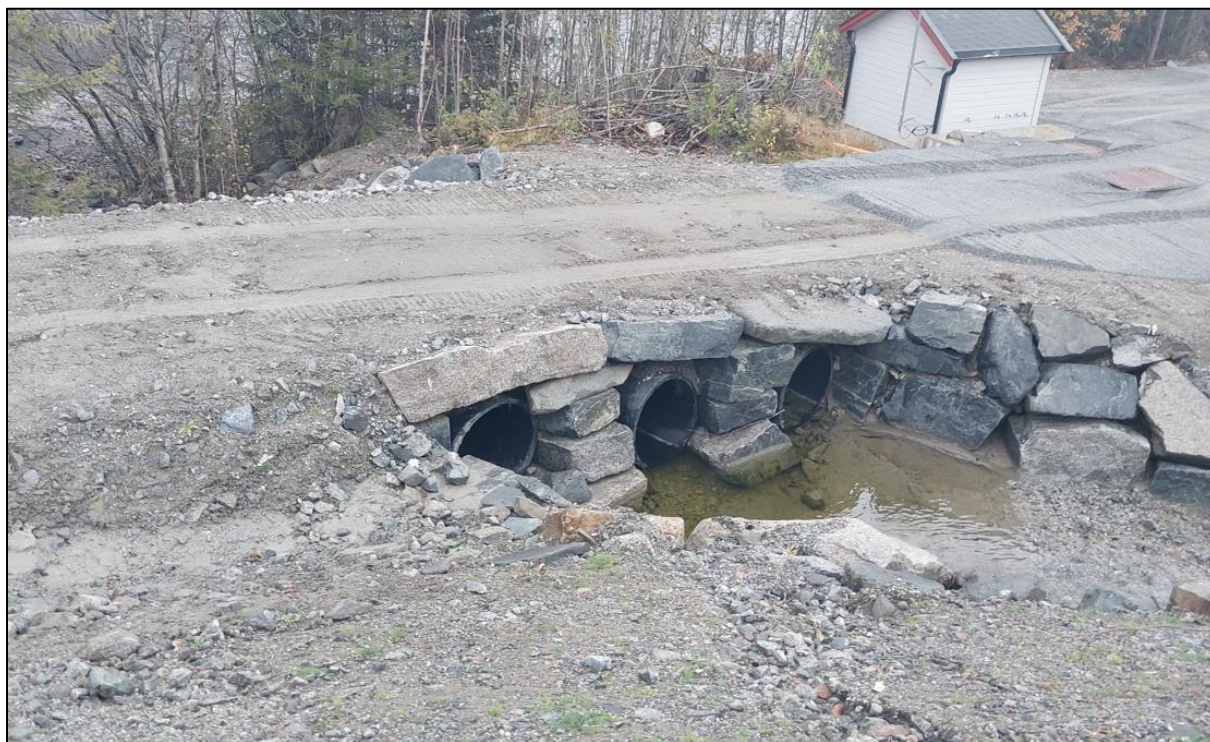
Figur 12: Delstrekning 7: 3 x 1000 mm rør.
