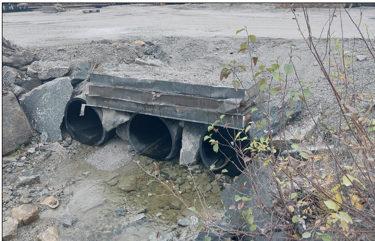
Figur 11: Delstrekning 6: 3 x 1000 mm rør.
