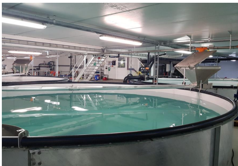
Figur 20. Startfôringskar med fôringsanordning.
