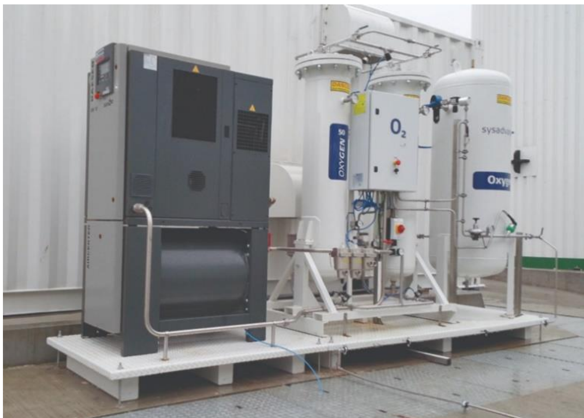
Figur 56. Oksyngenerator på skid som kan installeres inhouse i anlegget, eventuelt i container som står utendørs. Oksyngengeneratorene strippe oksygen fra lufta og produserer oksygen med 92 – 95% renhet.
