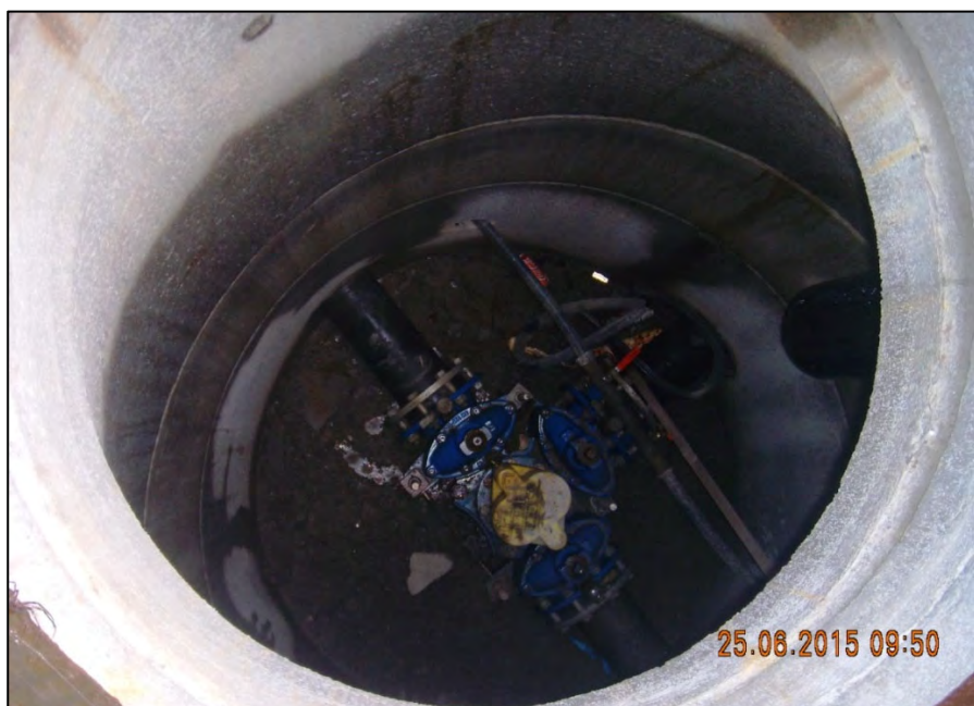
Figur 5: Eksisterende kum K2980 i Oppsatavegen
