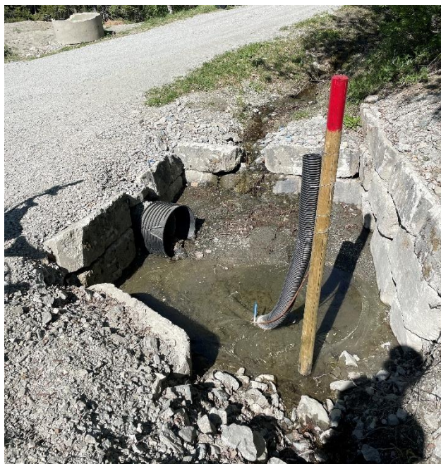
Figur 8: Eksempel på utforming av masseavlagringsbasseng foran stikkrenner i Ål.
