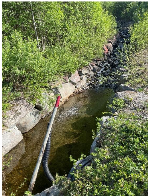
Figur 8: Eksempel på utforming av masseavlagringsbasseng foran stikkrenner i Ål.
