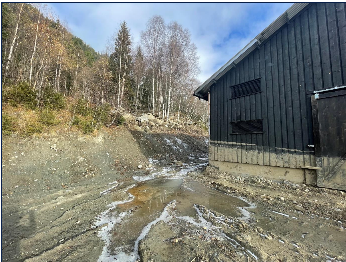
Figur 3: Utløp av skred ved Halvorstølen (ID3). Massene har stått ca. 1,5 meter opp langs bakveggen av bygningen. Det er ingen store skader på bygningsmassen.
