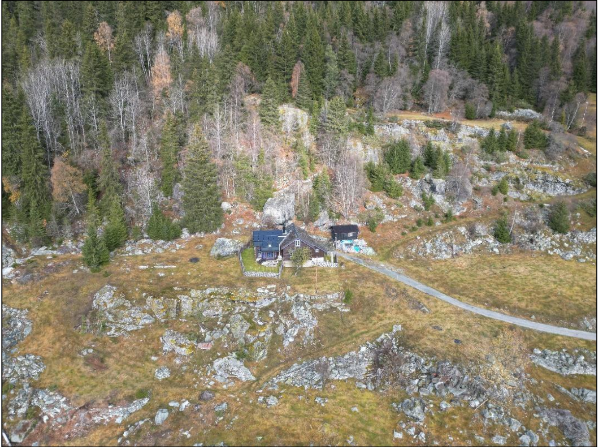
Figur 4: Bildet viser en stor avsatt blokk bak Skottebølvegen 81 og enkelte skreter med løsnestannsynlighet større enn 1/1000 i området bak huset. Det er også løstneområder for steinsprang med årlig sannsynlighet lengre opp i skråningen, utenfor bildet. Bildet er tatt mot nord, med drone på befarng.
