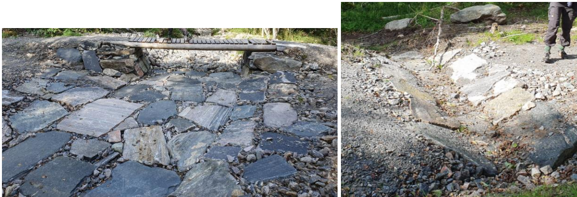
Figur 9: Senket og steinsatte lavbrekk over veg. Foto: Ingvild Brekke, Skred AS
