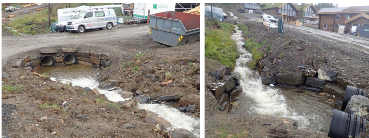
Figur 8: Eksempel på utforming av masseavlagringsbasseng foran stikkrenner.
