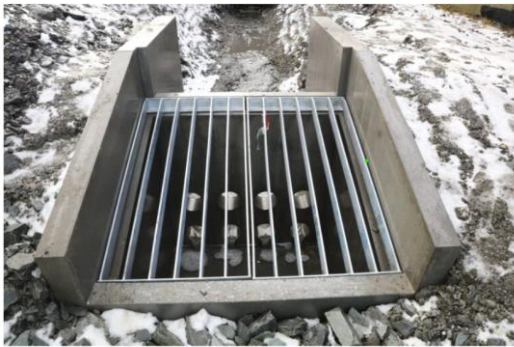
Figur 2: Eksempel på selvrensende bekkeinntak, «NIFS Vossing» fra NOBI.
