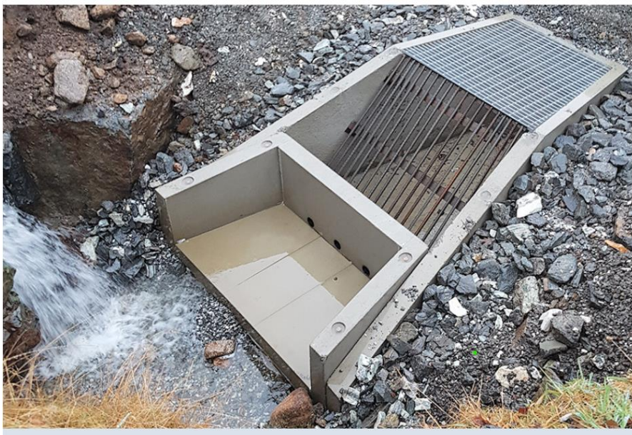
Figur 3: Eksempel på inntak med oppsamlingskasse som kan løftes av fra «Vossatrauet».
