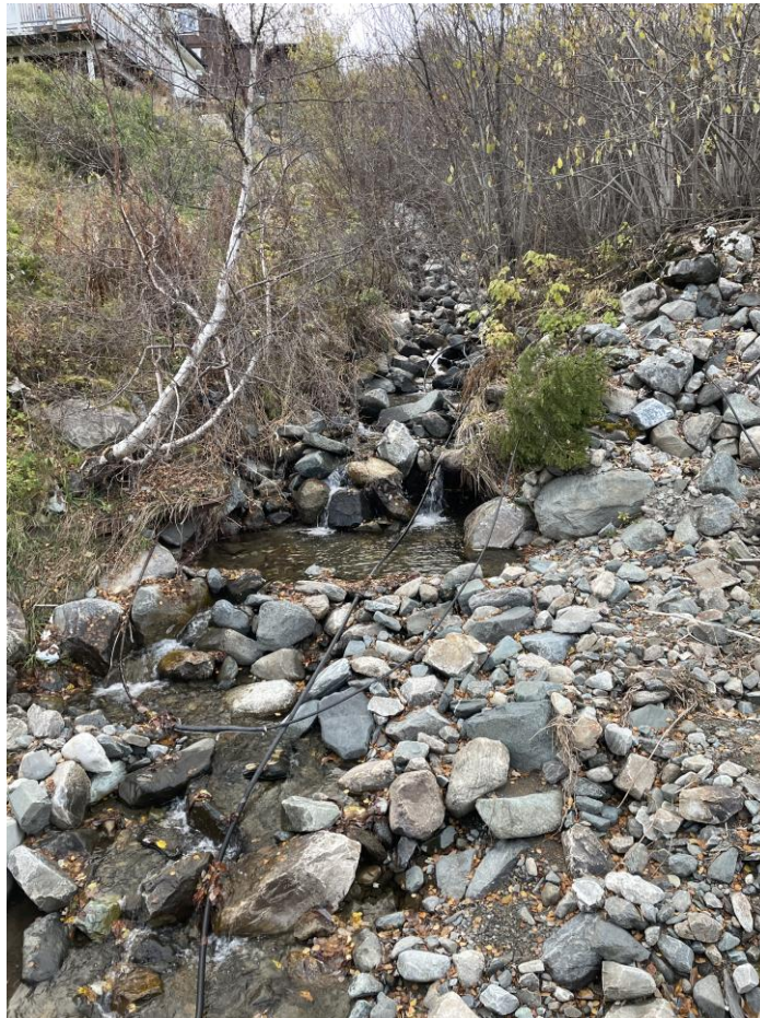
Figur 13: Bilde fra punkt 5B ved Teigengutu/Øvre Ålsveg.
