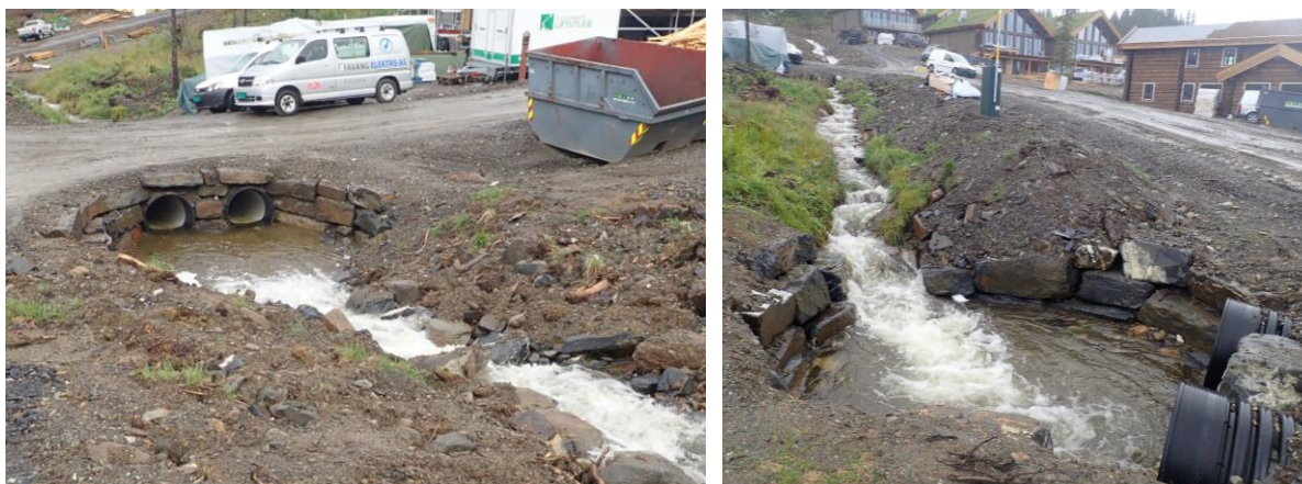
Figur 6: Eksempel på utforming av masseavlagringsbasseng foran stikkrenner.
