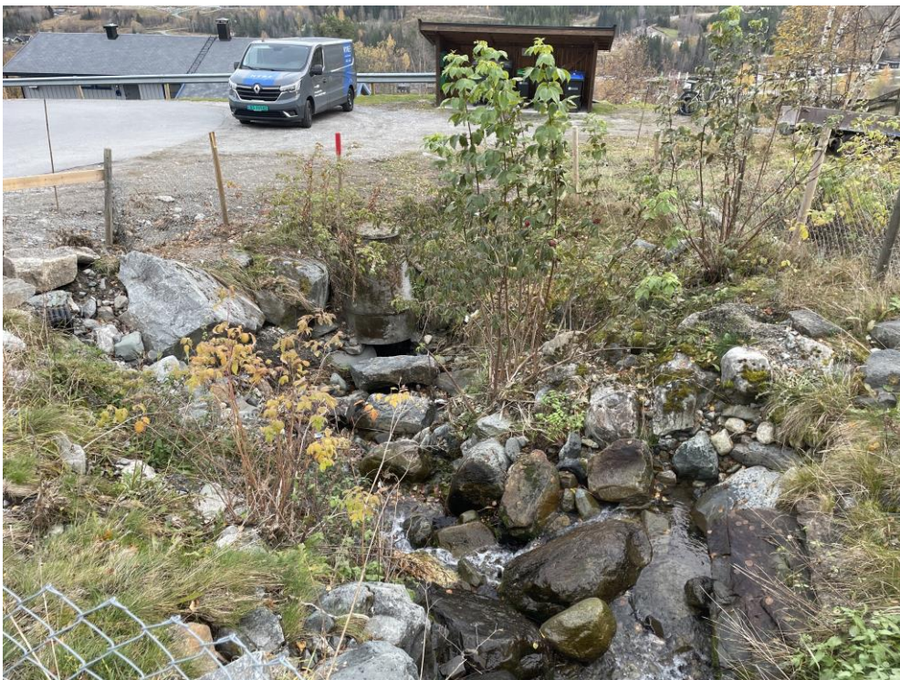
Figur 16: Inntaket til Stavegrove ved Leksvolvegen punkt 6D.
