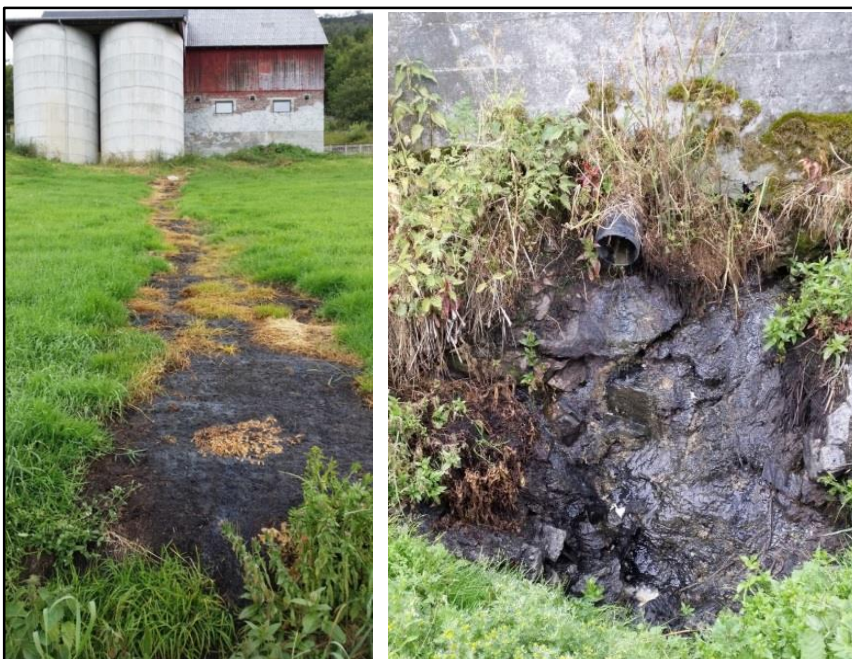
Figur 6. Bilete til venstre syner døme på utslipp av silopresssaft frå ein kum for silopresssaft kor det renn over. Bilete til høgre syner silopresssaft som siger ut frå ein utett tårnsilo (bilete frå Nordfjord)
