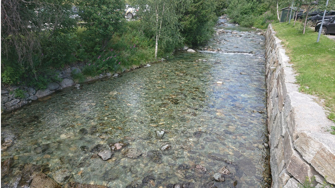
Figur 5. Strekningen rett oppstrøms den øvre terskelen er strengt kanalisert og har nokså ensarta bunns substrat.
