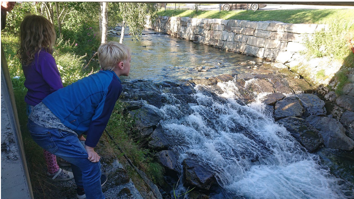
Figur 4. Den øverste terskelen ved brua i Hemsedal sentrum er trolig problematisk for fisk.
