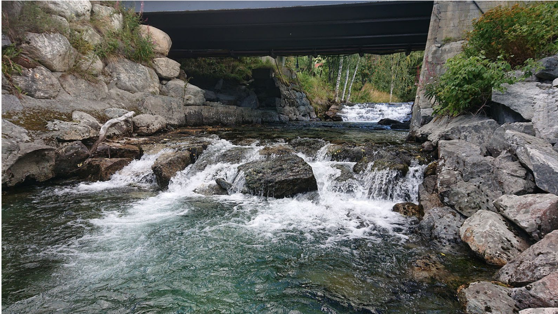
Figur 3. Ved brua i sentrum er det anlagt to tydelige terskler der særlig den øverste vurderes å være problematisk for ørret på veg opp fra Hemsila.
