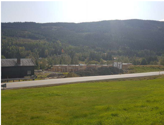
Støyvoll ved RV7 bygd og innkjøring stengt.
