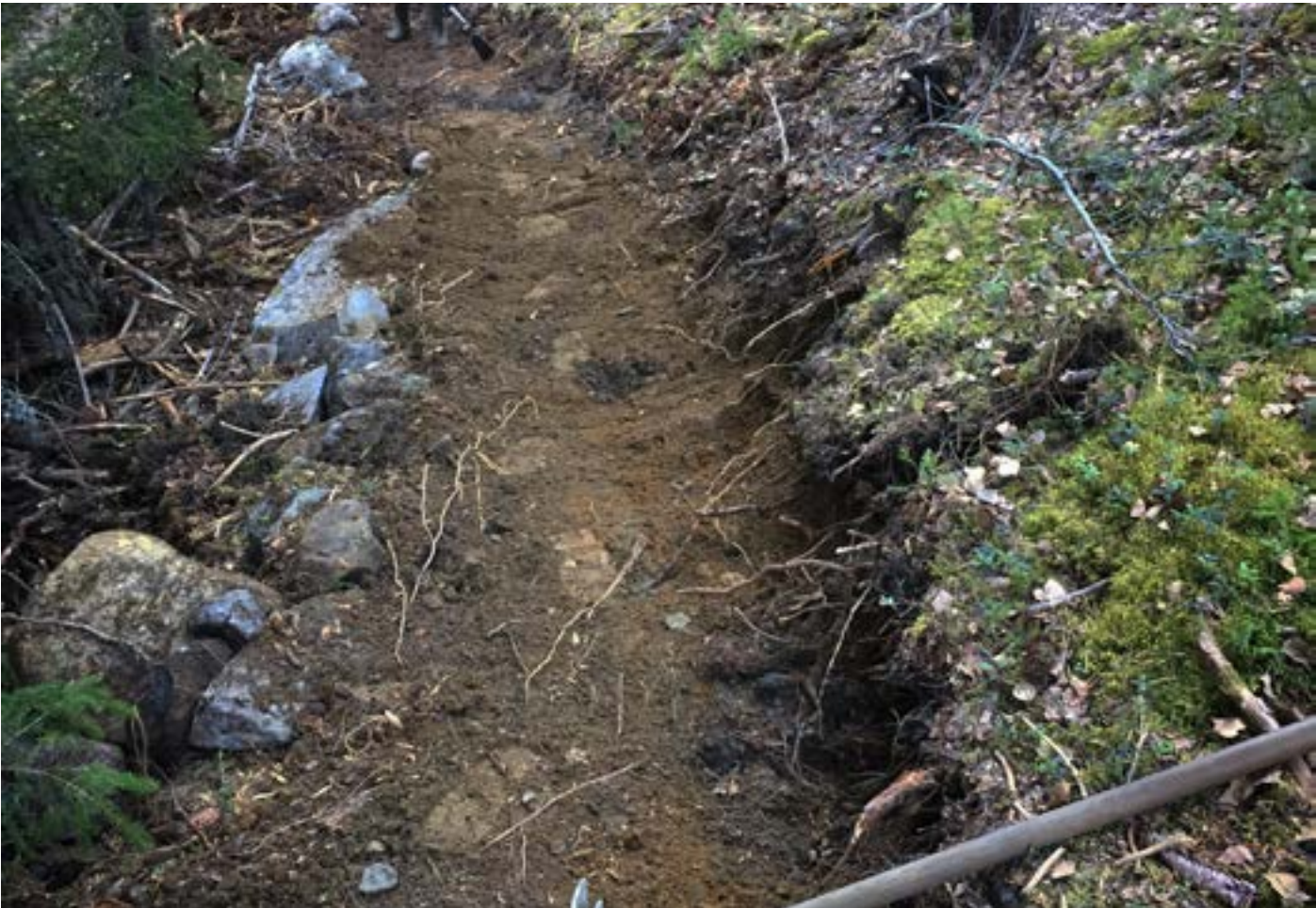
Eksempel på sykkeloptimalisert sti under konstruksjon (SO.S)
