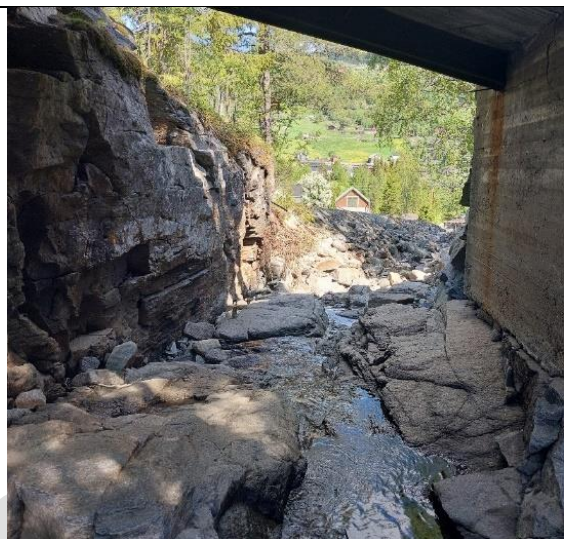
Brua til hovedløpet ved Strandalivegen
