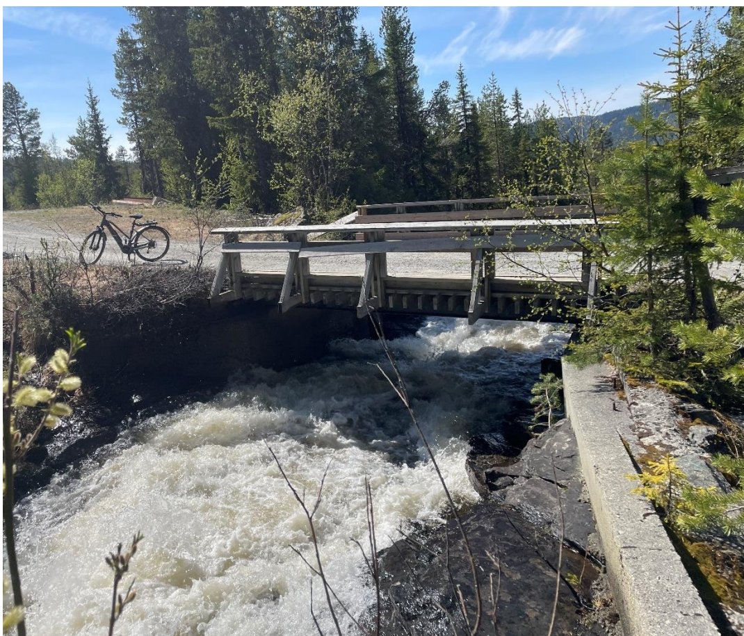
Figur 19: Bru over Kulu ved Nysetvegen.
