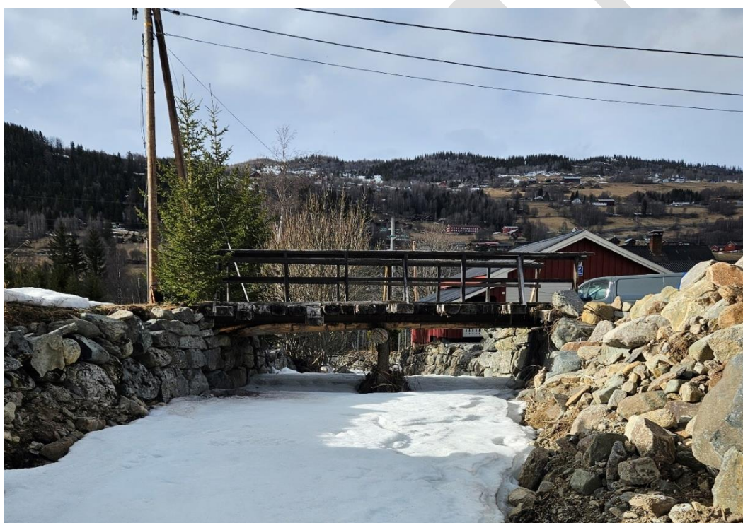
Figur 8: Gangbru mellom Strandalivegen 106 og 118.
