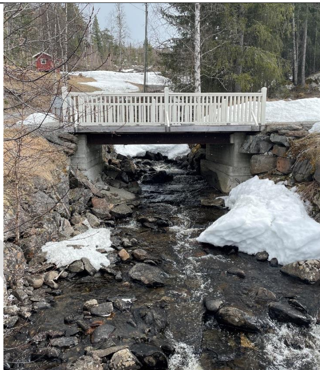
Brua ved Strandalivegen 232
