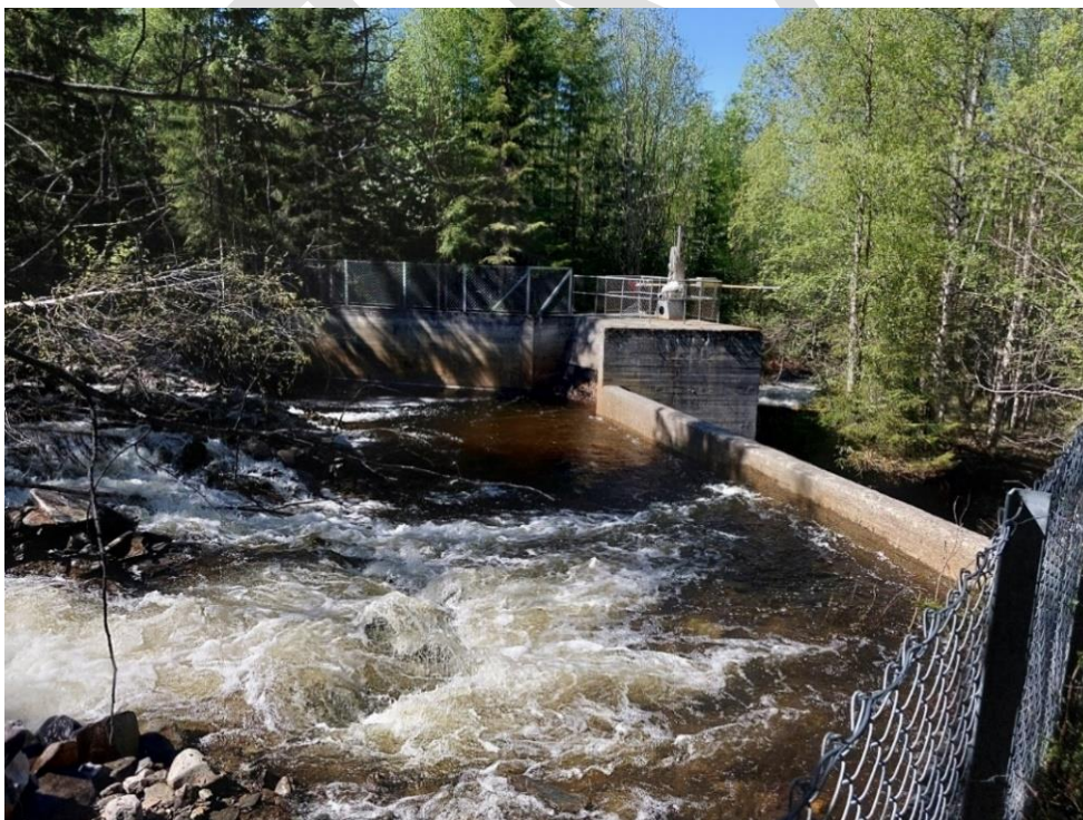
Figur 7: Dammen ved Tunga med luka mot vestre løp og overløpsterskel mot østre løp.
