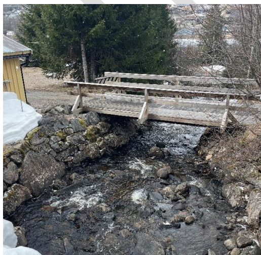
Brua ved Strandalivegen 230
