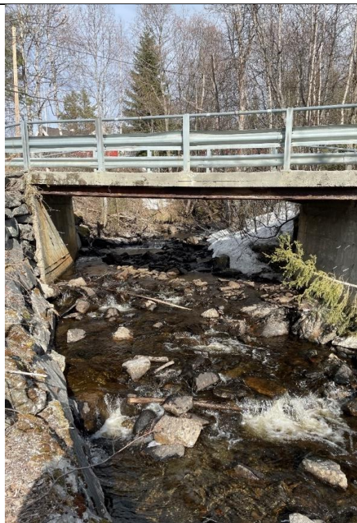
Den øverste brua ved Strandalivegen 155
