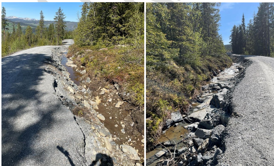
Figur 20: Spor etter vann i veigrøfta langs Nysetvegen.
