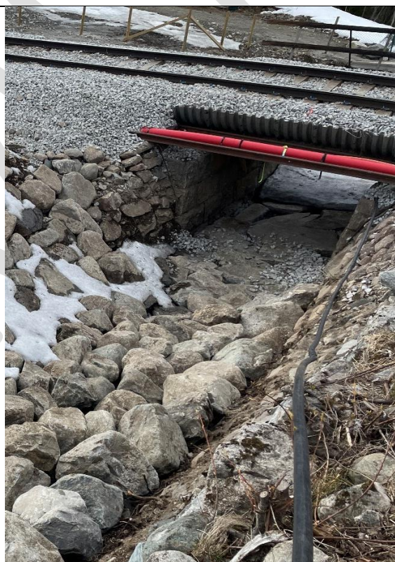
Jernbaneundergangen til hovedløpet
