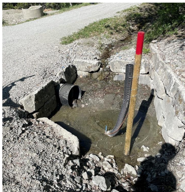
Figur 8: Eksempel på utforming av masseavlagringsbasseng foran stikkrenner i Vestlia.
