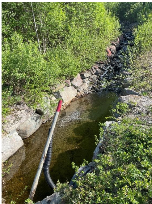
Figur 8: Eksempel på utforming av masseavlagringsbasseng foran stikkrenner i Vestlia.
