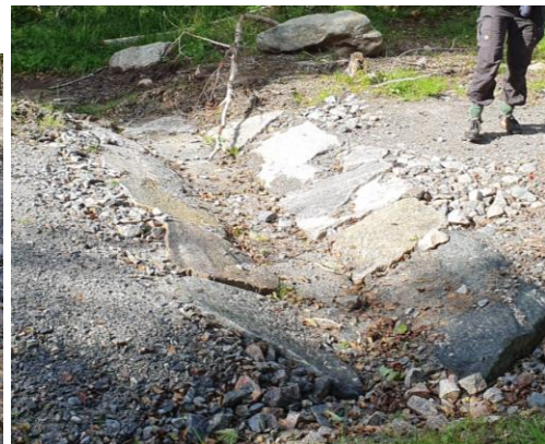
Figur 9: Eksempel på senket og steinsatte lavbrekk over veg. Foto: Ingvild Brekke, Skred AS.
