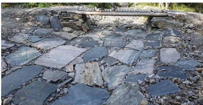
Figur 9: Eksempel på senket og steinsatte lavbrekk over veg. Foto: Ingvild Brekke, Skred AS.
