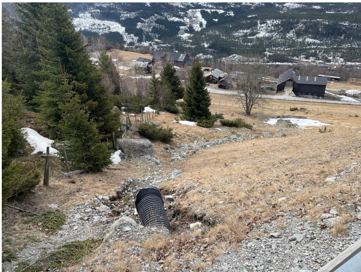
Foto av utløpet fra 14B med Sørbøen i bakgrunnen.
