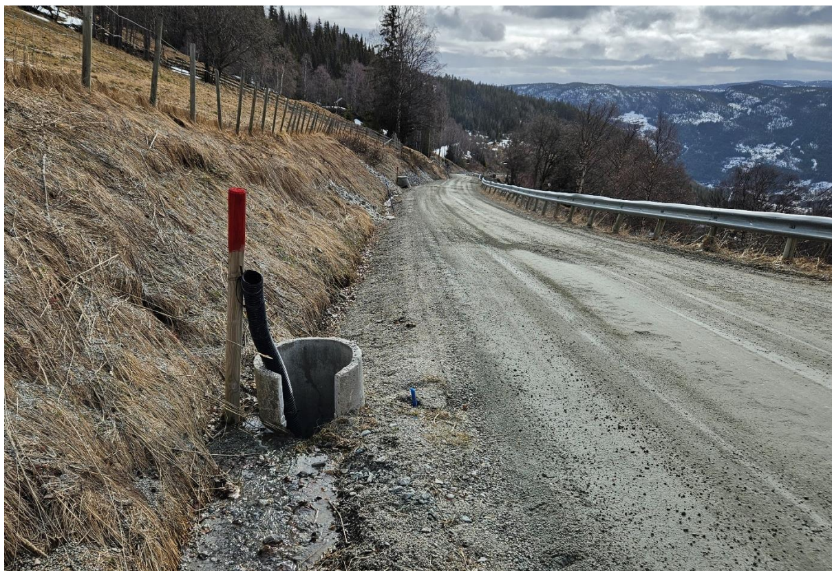
Foto av inntaket til stikkrenna i 10A i forgrunnen, og 10B i bakgrunnen.
