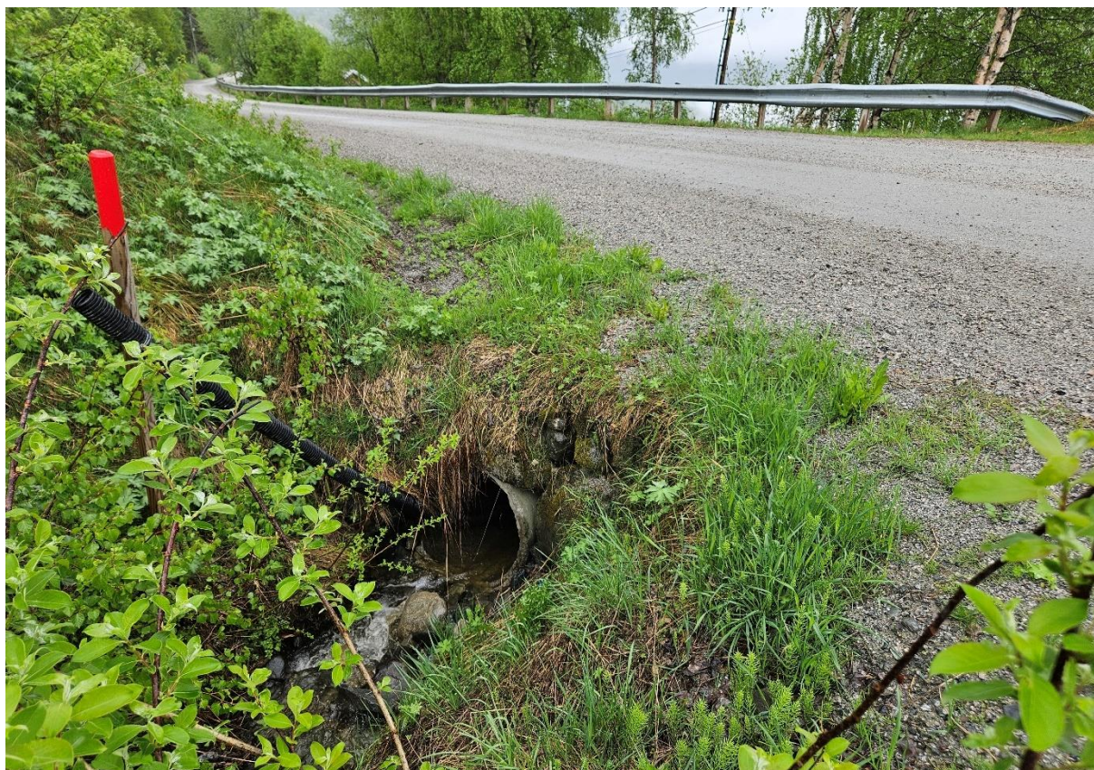
Bilde av innløpet til 6C og flomveien som i hovedsak forventes å følge Liagardsvegen nedover.
