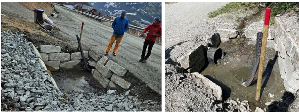
Figur 10: Eksempel på utforming av masseavlagringsbasseng foran stikkrenner fra Ål.
