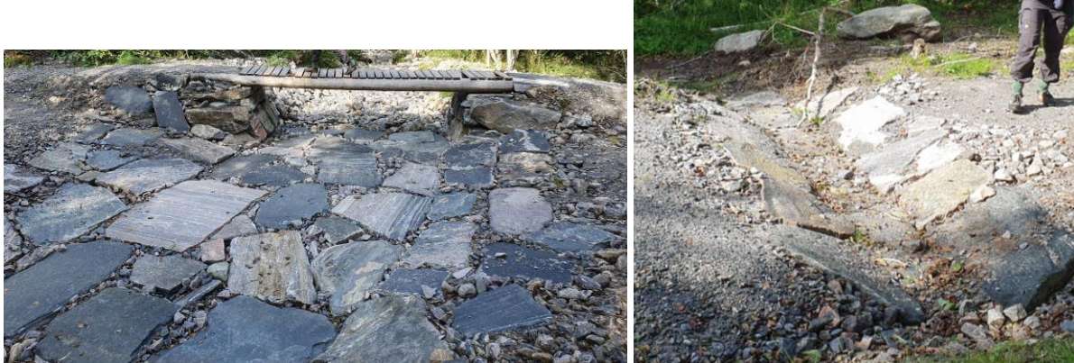
Figur 11: Senket og steinsatte lavbrekk over veg. Foto: Ingvild Brekke, Skred AS
