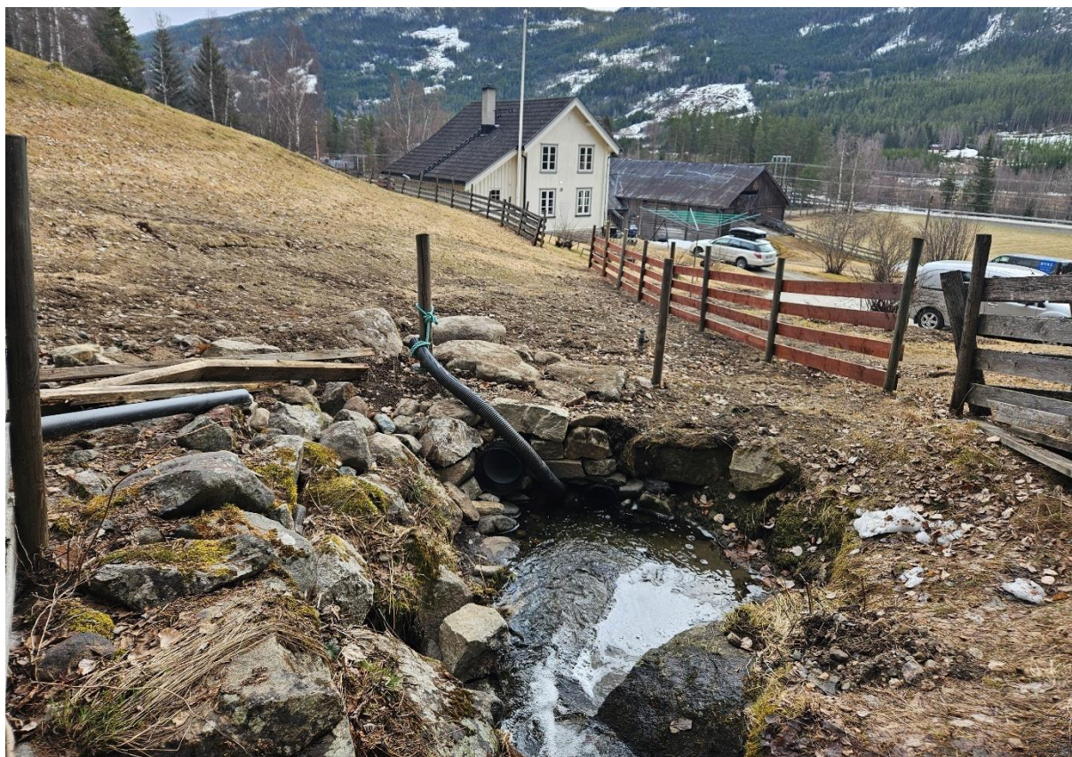
Bilde av innløpet til stikkrennene på Nedre Moen (16D), der vann relativt hyppig vil dra over gårdsplassen.
