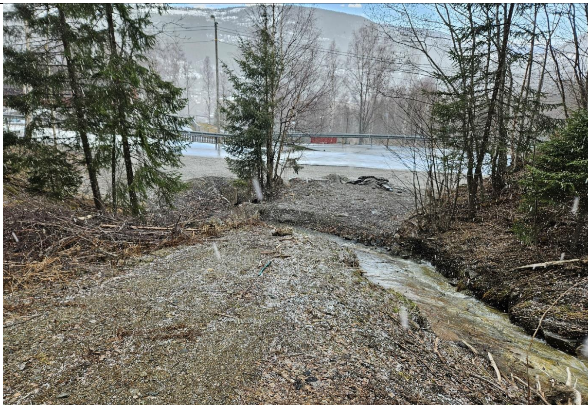
Bilde av knekken i bekkeløpet rett oppstrøms 8E (Oppsatavegen) der vannet vil vaske ut massene som er lagt opp og dra rett ut til veien.
