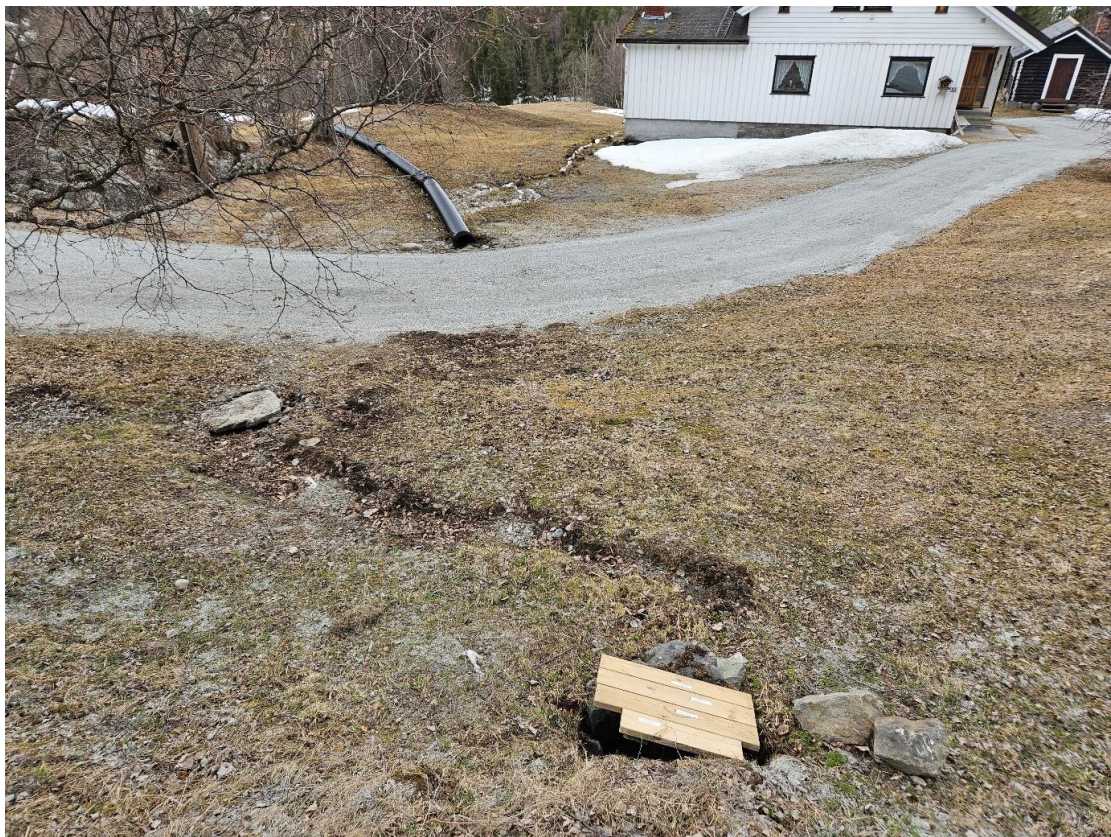
Bildet er tatt fra 1D og ned mot Fåbrunnsjøta og viser de provisoriske tiltakene som er utført etter vann på avveie over tunet.
