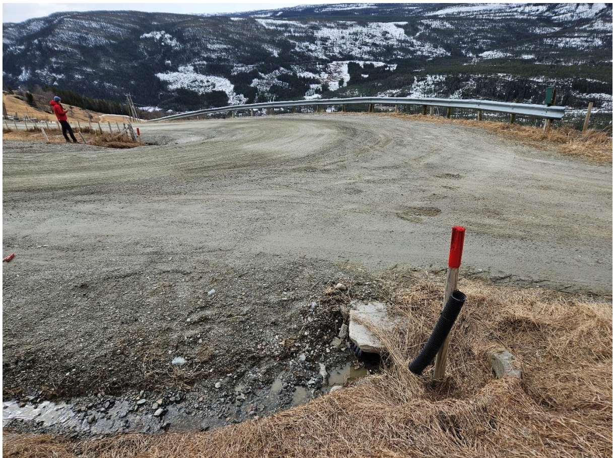
Innløpet til 12D i forgrunnen og utløpet i innersvingen bak til venstre på bildet.
