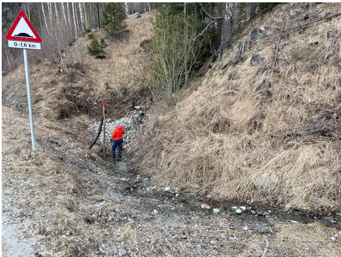
Foto av stikkrenna i 9F, der det kan være aktuelt å legge bedre til rette for avsetning av masser.
