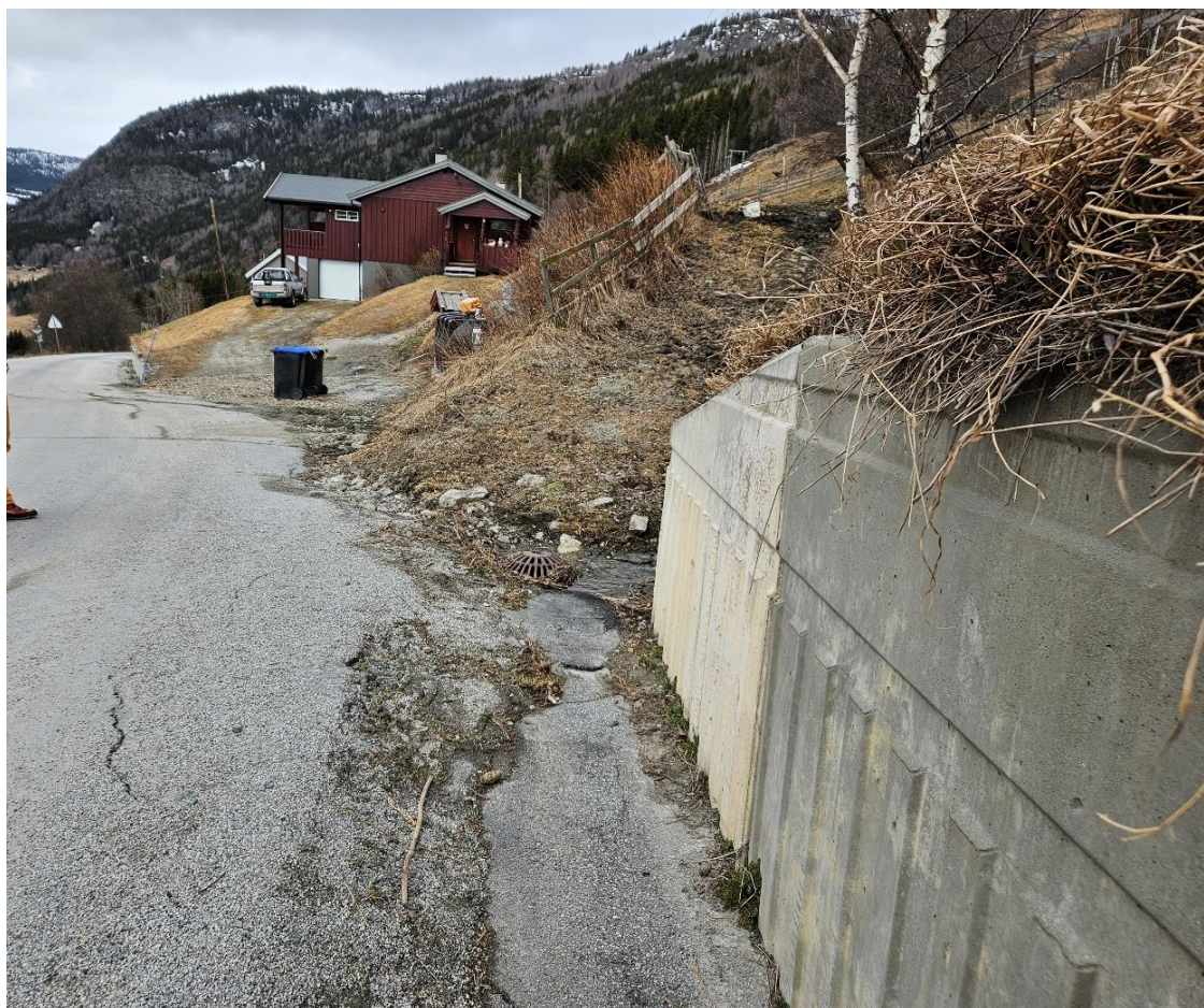
Foto av rista i 11C viser at det er bratt terreng og lite plass til tiltak langs vegen.
