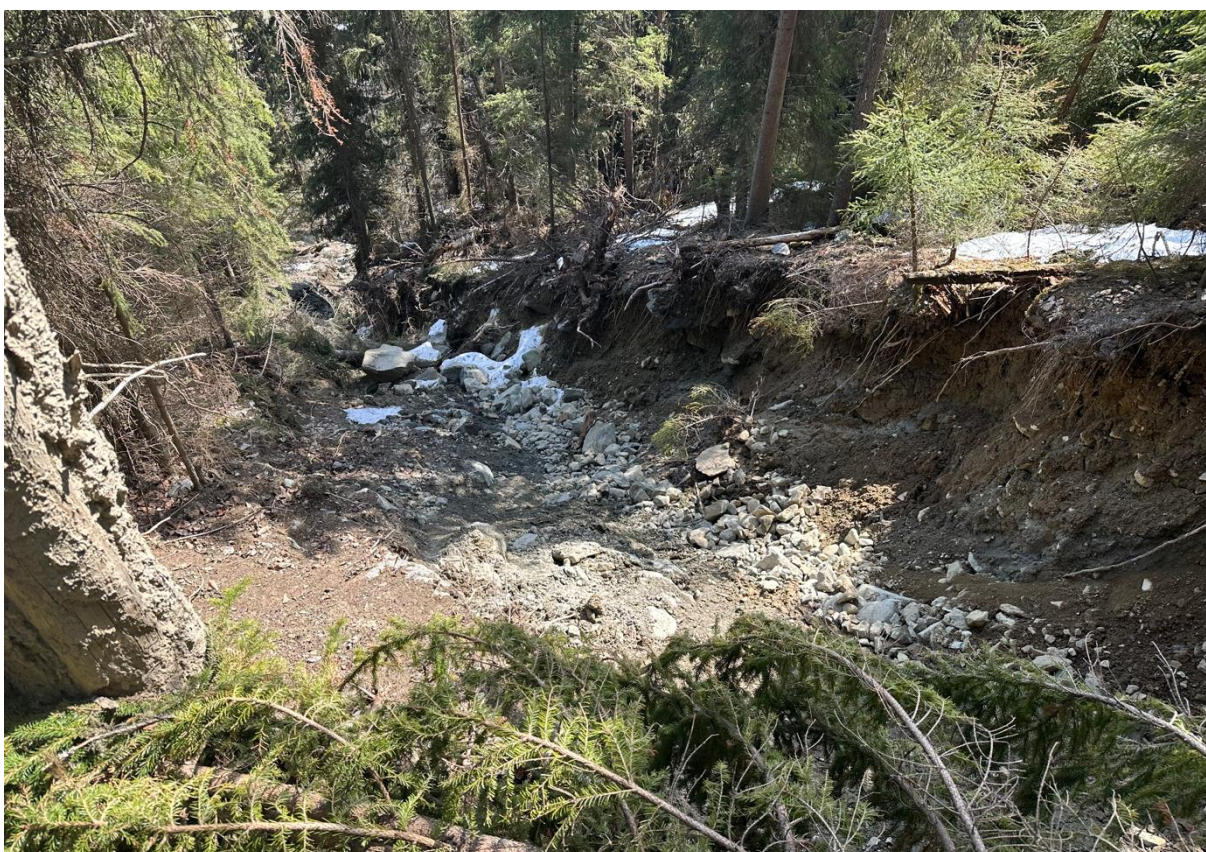
Figur 10: Stor erosjon i løsmassedekket under klippepartiet. "Mudmarks" høyt på trær nært skredløpet.
